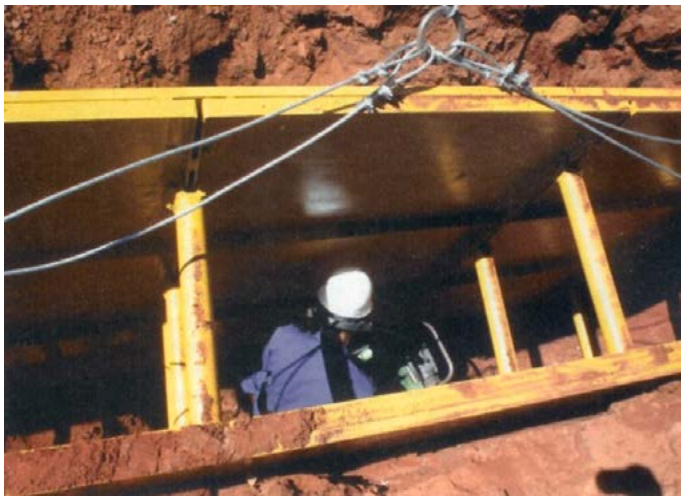
Figura 10 - Escoramento móvel para trabalho em valas da CITAGUA.
