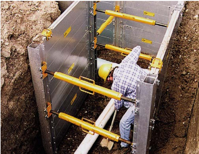
Figura 8 - Escudamento de alumínio modular BUIL-A-BOX® da Efficiency Production Inc.
