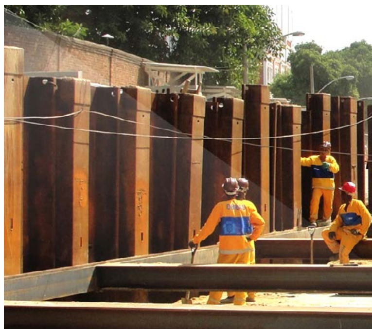
Figura 2 - Escoramento com pranchas verticais
