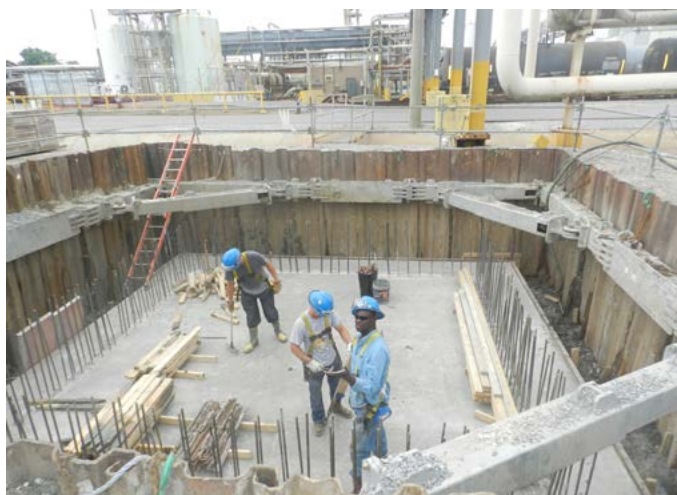
Figura 6 - Poço retangular com pranchas de madeira com escoramento tipo EXCAVATION BRACES® Speed Shore Inc
