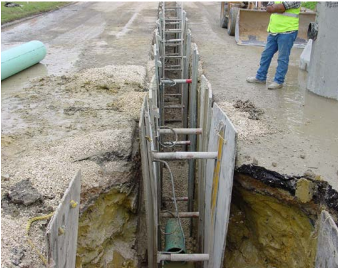
Figura 7 - Aplicação do escoramento VERTICAL SHORE® da Speed Shore Inc. diretamente sobre o solo, sem utilização de paredes.
