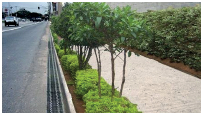
Exemplo do que seria a combinação de valetas drenantes e calçadas ajardinadas
