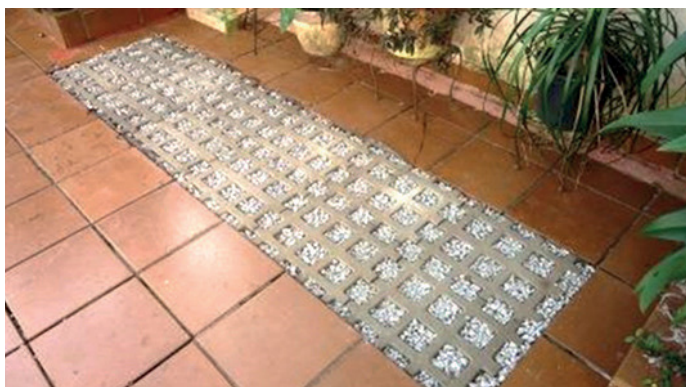
Dispositivo doméstico de acumulação/infiltração já instalado em plena operação
