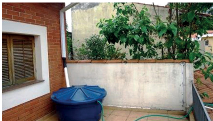
Dispositivo doméstico para acumulação e uso de águas de chuva através de recolhimento das águas pluviais incidentes sobre o telhado
