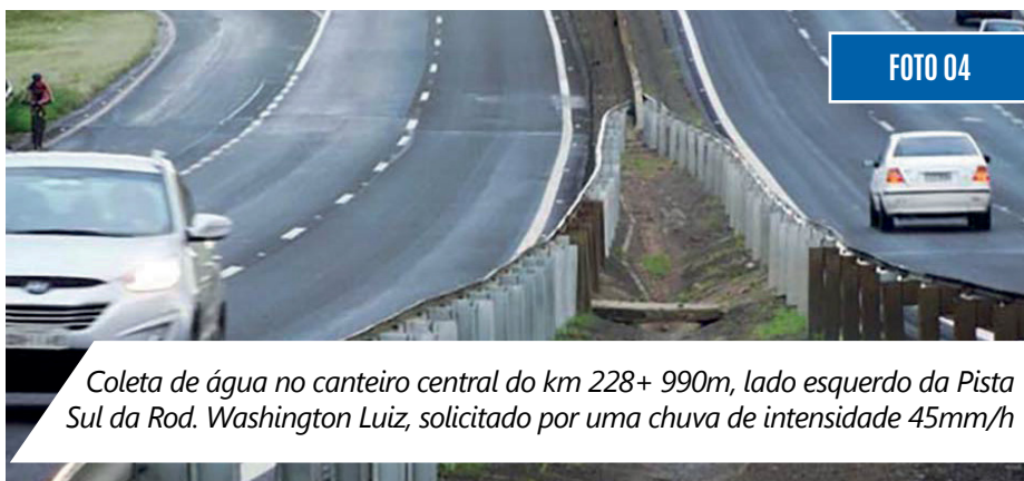
Superfície de rolamento da Pista Sul da Rod. Washington Luiz, entre o km 228 e 229 + 400m, sob chuva de estimados 40mm/h
