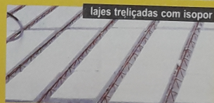
lajes treliçadas com isopor
