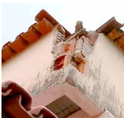
II - Descarga na cobertura de uma casa
